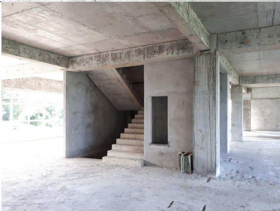
Foto 31 – Vista da escada do segundo andar para o terceiro andar. Alvenarias marcadas, levantadas e rebocadas.
