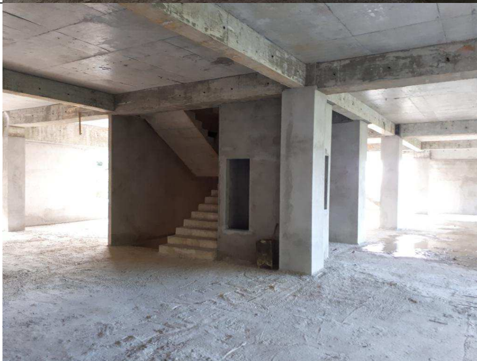
Foto 18 – Vista da escada central (primeiro andar para o segundo andar). Alvenarias já marcadas e levantadas e rebocadas.
