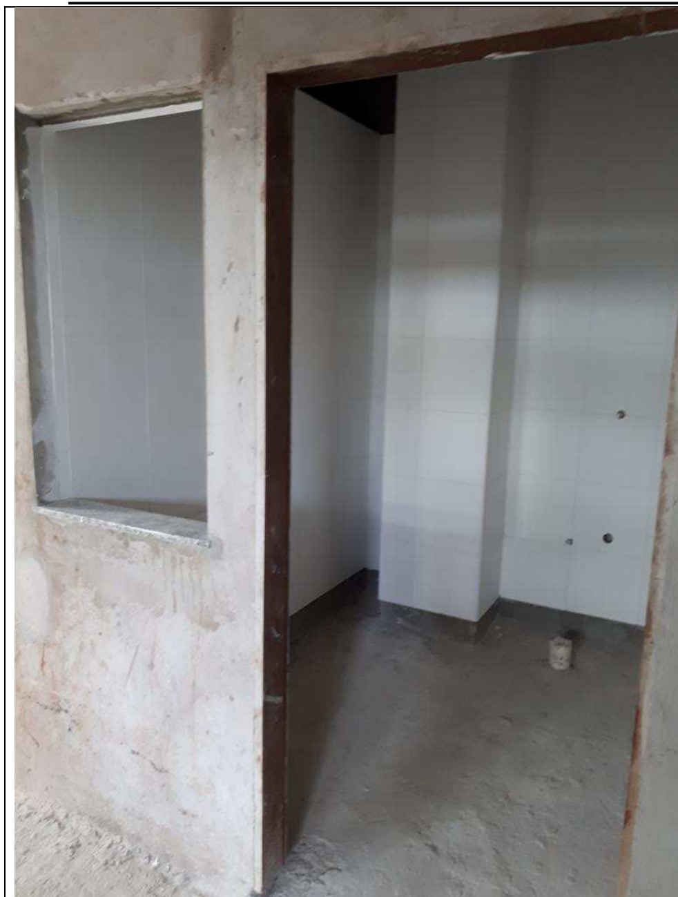
Foto 23 – Vista interna do DML do primeiro andar. Revestimento cerâmico das alvenarias sendo aplicado. Instalação hidráulica e de esgoto executadas.
