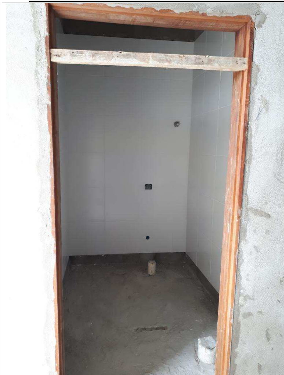
Foto 54 – Vista interna do Sanit PNE Masc. do terceiro andar. Detalhe das alvenarias rebocadas.
