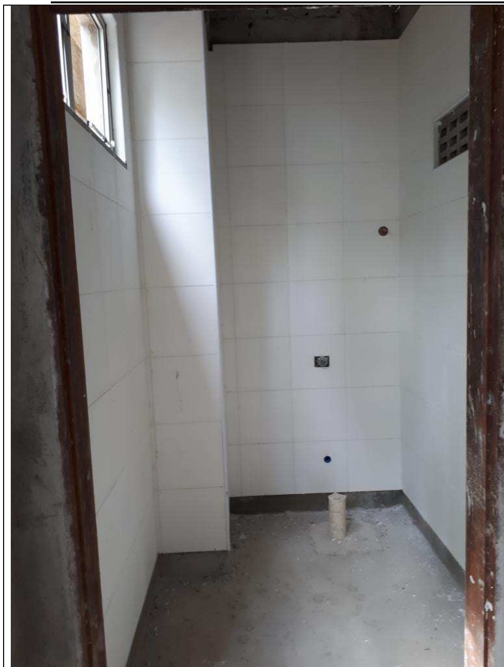
Foto 15 – Vista interna do Sanit PNE Fem. Revestimento cerâmico das alvenarias já aplicado.
