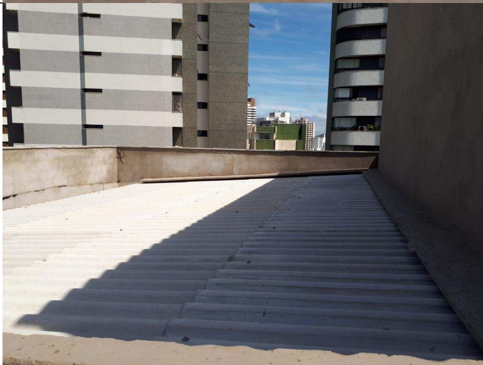
Foto 59 – Vista geral da laje de cobertura. Platibanda, calha de drenagem e madeiramento da cobertura executados e telhas instaladas.
