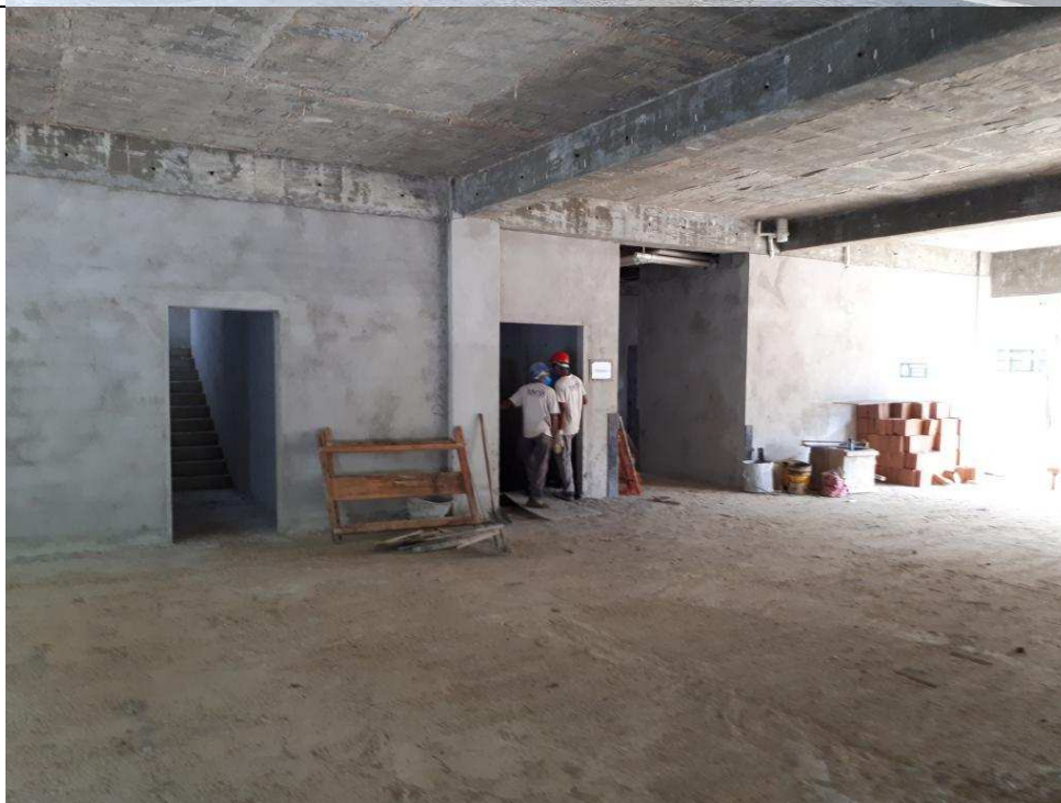
Foto 11 – Vista das alvenarias do térreo. Detalhe do vão da porta do elevador ao lado da entrada da circulação de serviço.
