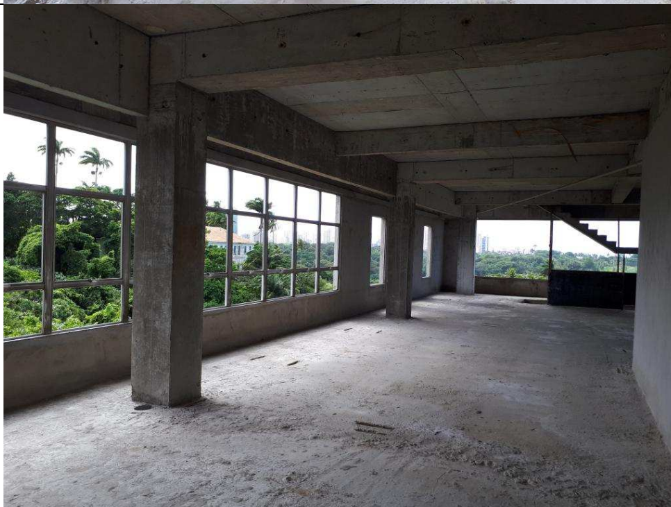
Foto 33 – Vista do segundo pavimento. Alvenarias marcadas levantadas e rebocadas. Esquadrias sendo instaladas.
