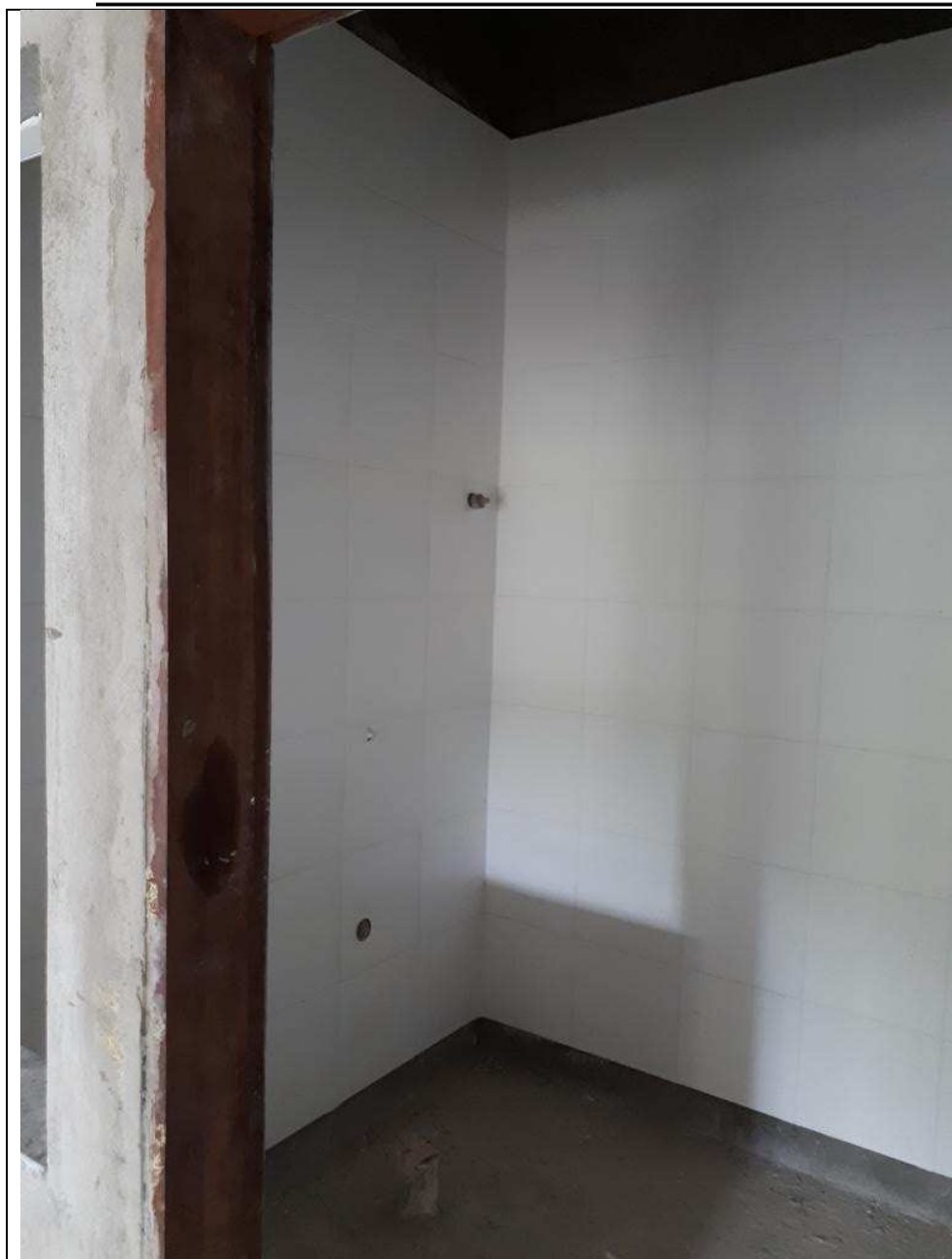
Foto 42 – Vista interna da copa do segundo andar. Detalhe das alvenarias rebocadas. Instalação hidráulica e de esgoto executadas.
