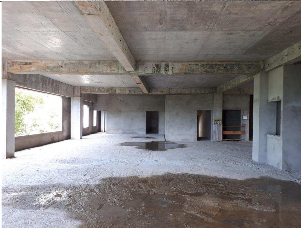
Foto 20 – Vista geral do Primeiro andar. Detalhe ao fundo das alvenarias já marcadas e levantadas e rebocadas.
