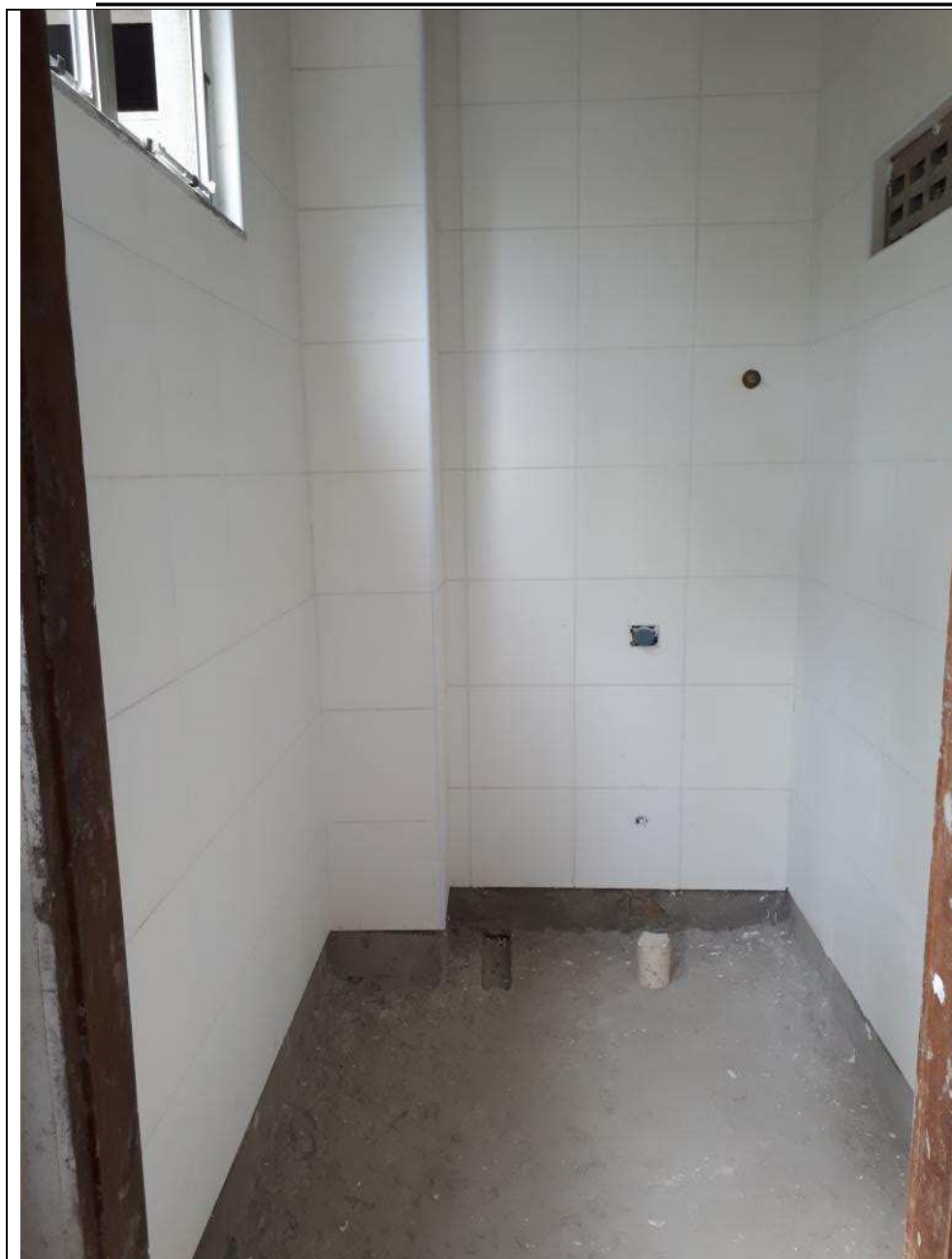
Foto 25 – Vista interna do Sanit PNE Fem. do primeiro andar. Revestimento cerâmico das alvenarias já aplicado. Instalação hidráulica e de esgoto executadas.
