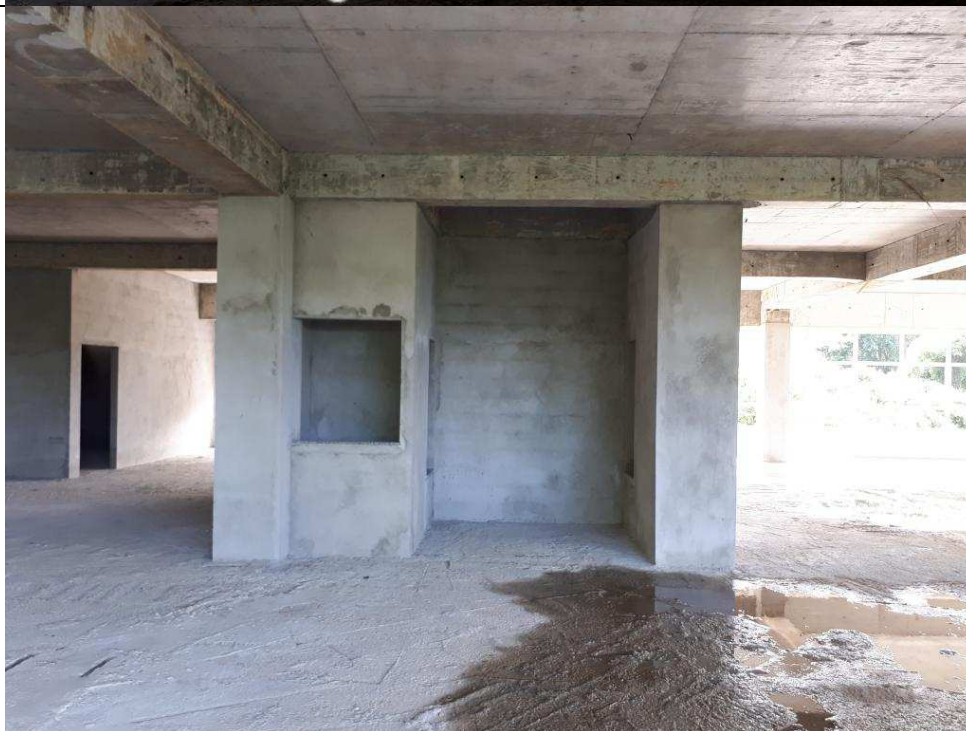
Foto 29 – Vista do primeiro andar. Alvenarias marcadas, levantadas e rebocadas.
