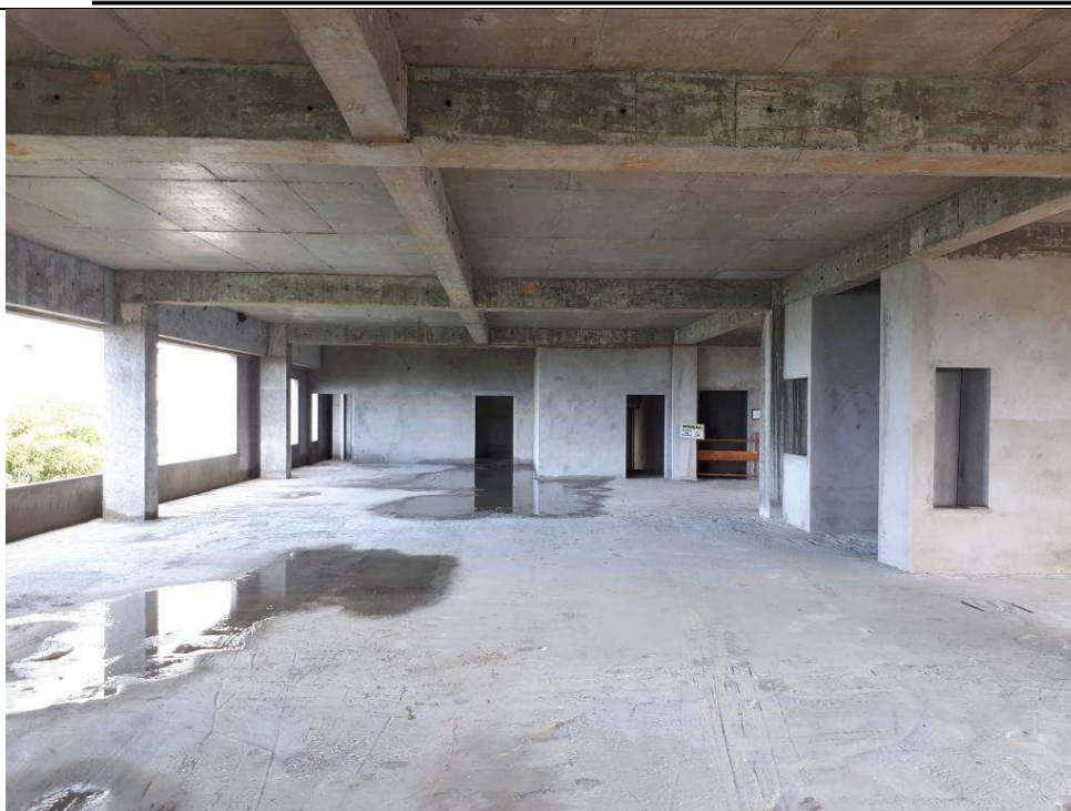
Foto 32 – Vista do segundo pavimento. Alvenarias marcadas levantadas e rebocadas.
