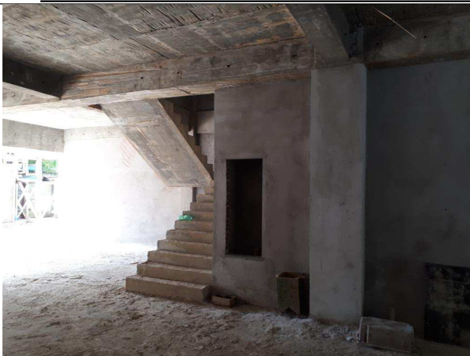
Foto 17 – Vista da escada central concretada (térreo para o primeiro andar)
