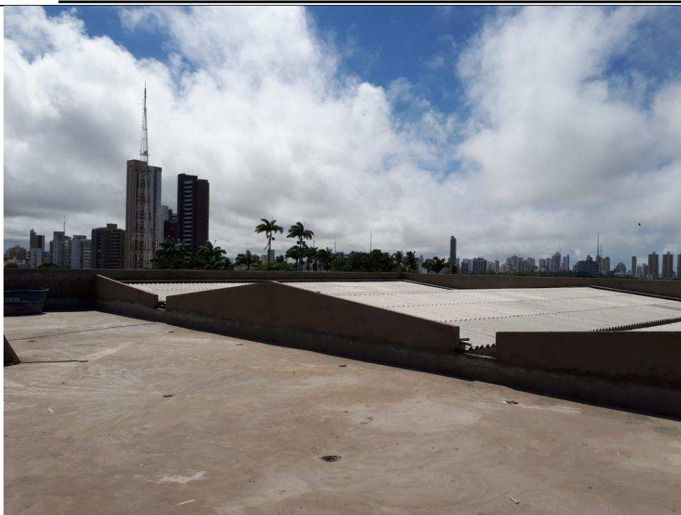
Foto 58 – Vista geral da laje de cobertura. Platibanda, calha de drenagem e madeiramento da cobertura executados e telhas instaladas.
