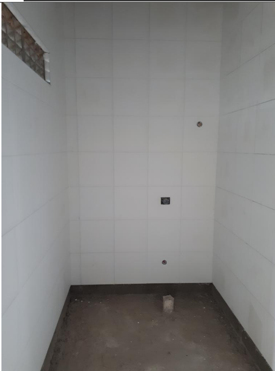
Foto 38 – Vista interna do Sanit PNE Masc. do segundo andar. Detalhe das alvenarias rebocadas. Instalação hidráulica e de esgoto executadas.
