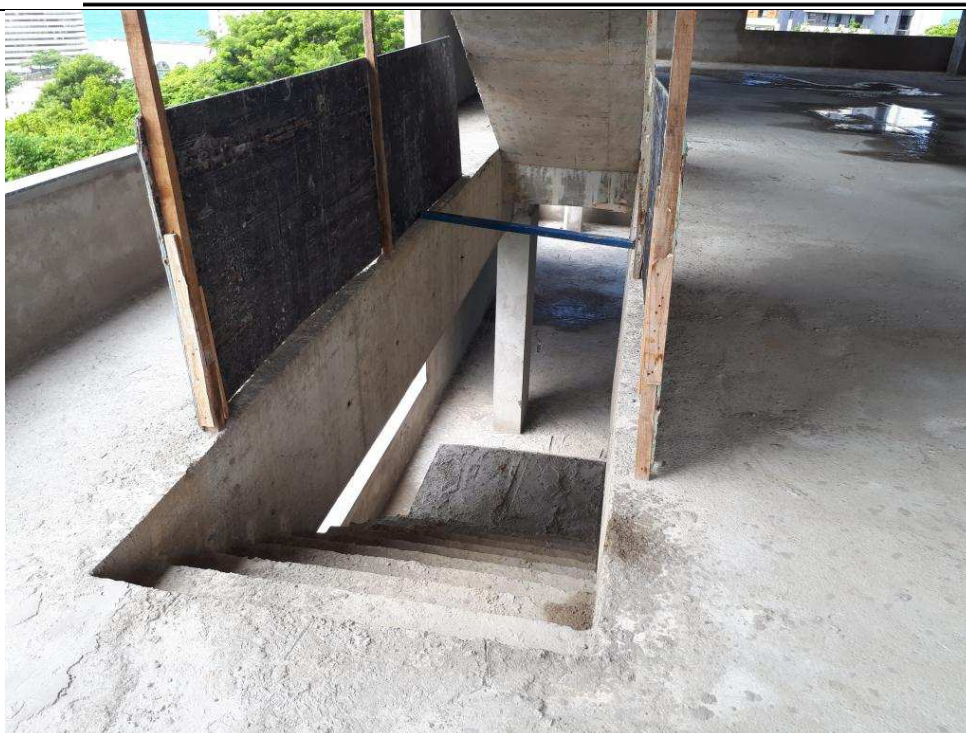
Foto 30 – Vista do segundo andar. Detalhe da escada entre acervos concretada e desformada.
