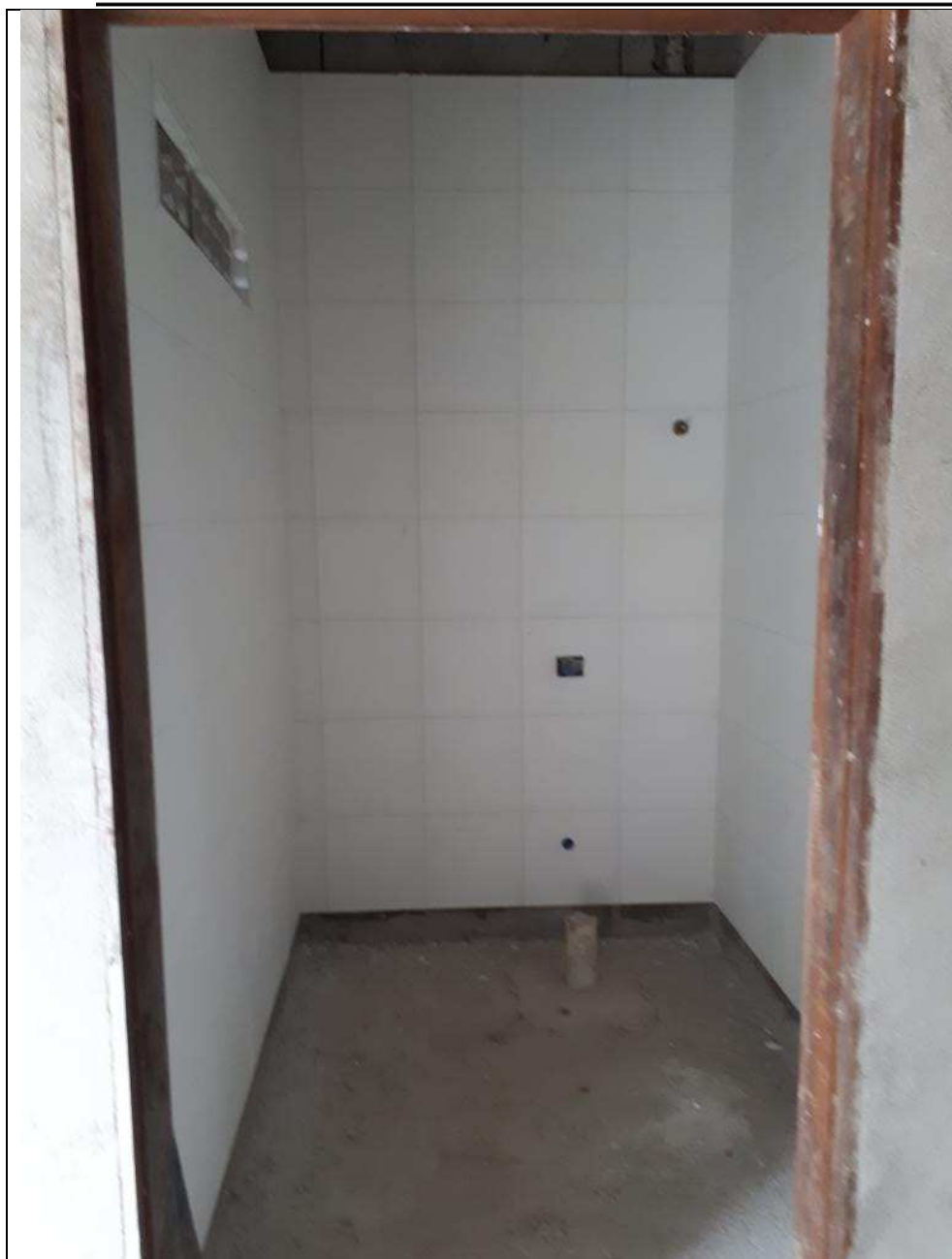
Foto 14 – Vista interna do Sanit PNE Masc no térreo. Revestimento cerâmico das alvenarias já aplicado.
