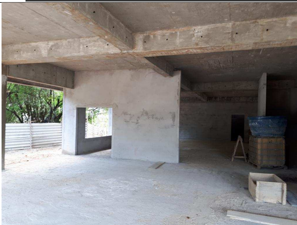
Foto 10 – Vista das alvenarias do térreo rebocadas e arestadas.
