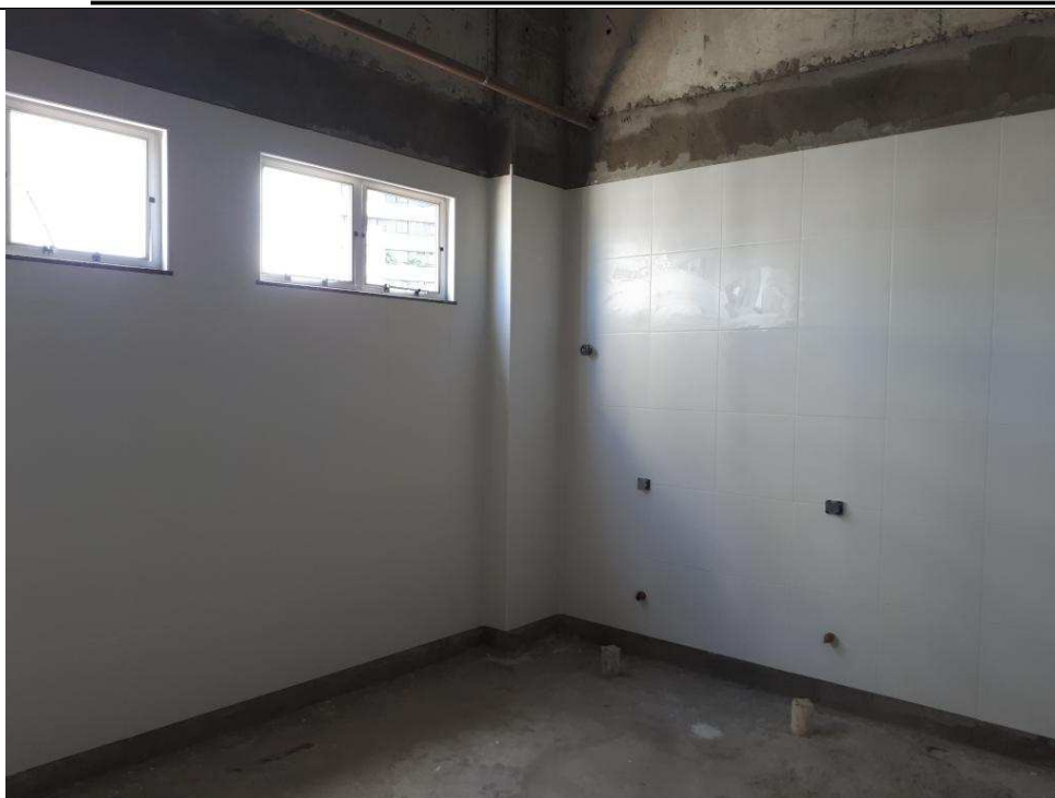
Foto 56 – Vista interna do Sanit Fem. do terceiro andar. Alvenarias executadas e rebocadas.
