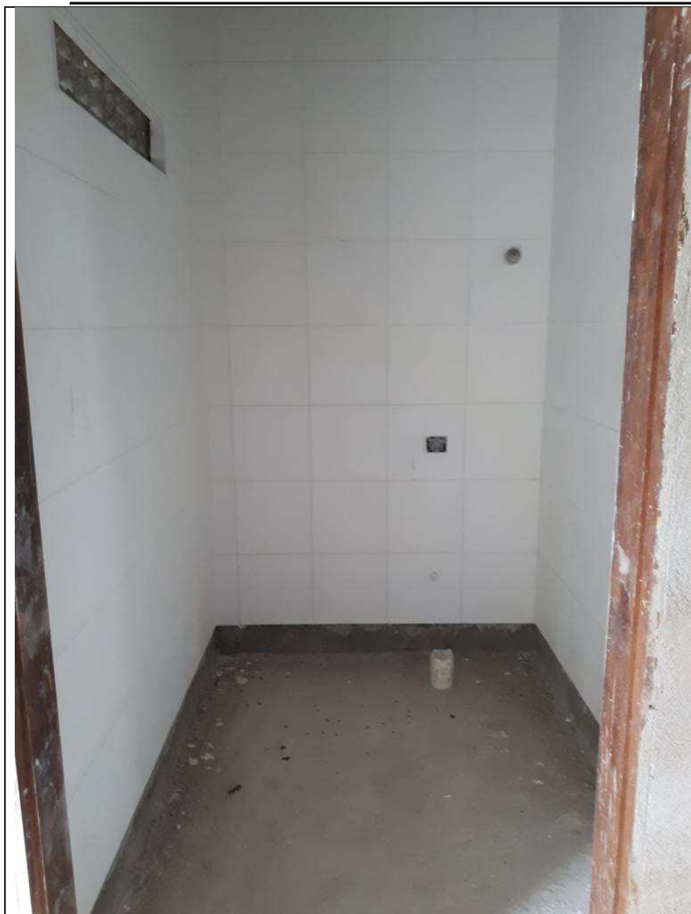
Foto 24 – Vista interna do Sanit PNE Masc. do primeiro andar. Revestimento cerâmico das alvenarias já aplicado. Instalação hidráulica e de esgoto executadas.
