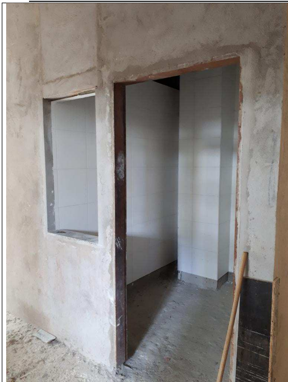
Foto 13 – Vista interna do DML no térreo. Detalhe do revestimento das alvenarias finalizado.
