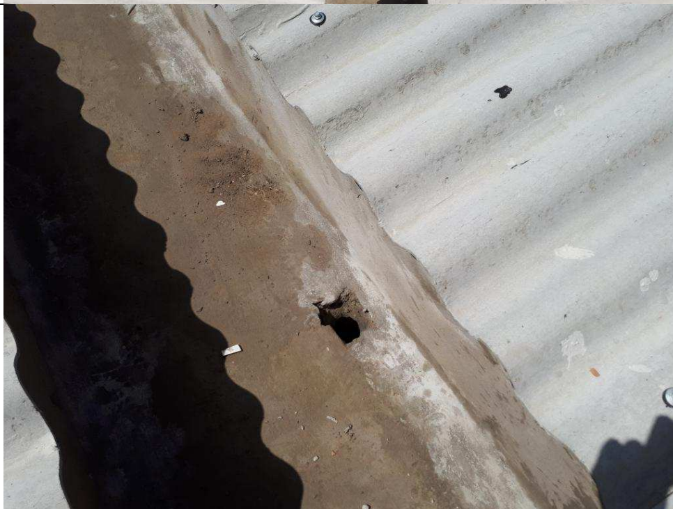
Foto 63 – Detalhe da descida pluvial sem o ralo instalado.
