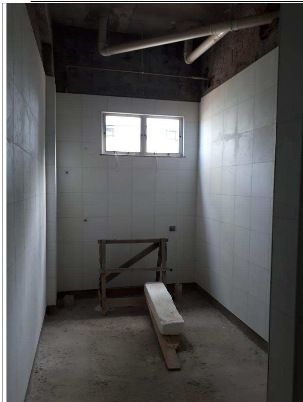
Foto 16 – Vista interna do Sanit Fem. Revestimento cerâmico das alvenarias já aplicado. Instalação hidráulica e de esgoto executadas.
