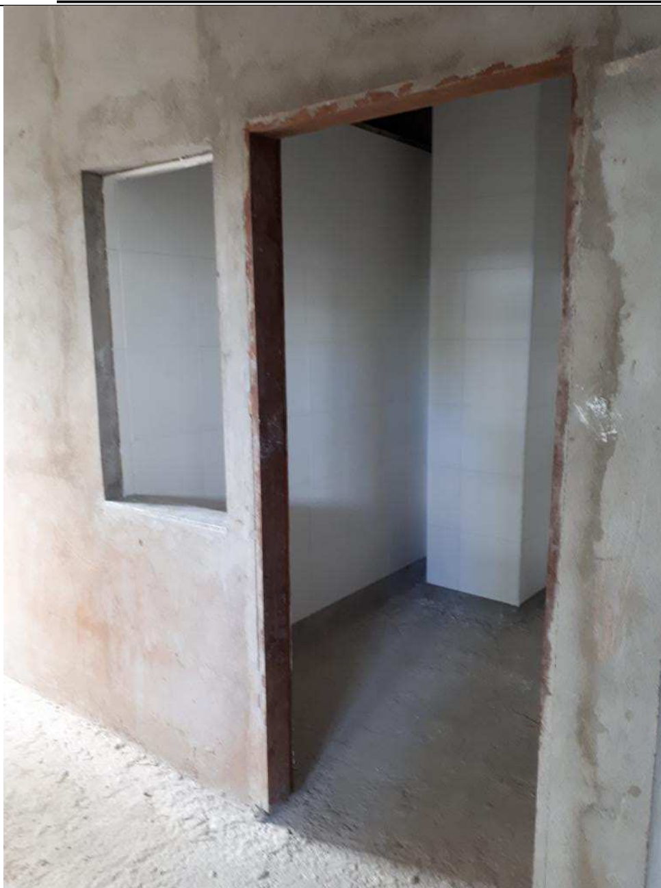
Foto 37 – Vista interna do DML do segundo andar. Detalhe das alvenarias sendo rebocadas.
