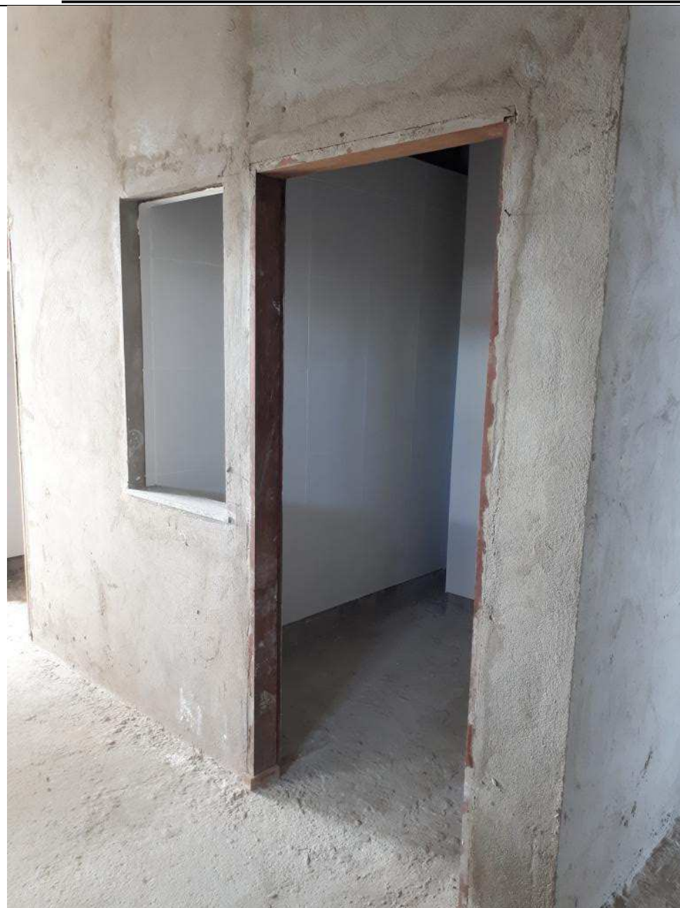
Foto 53 – Vista interna do DML do terceiro andar. Detalhe das alvenarias levantadas e rebocadas.
