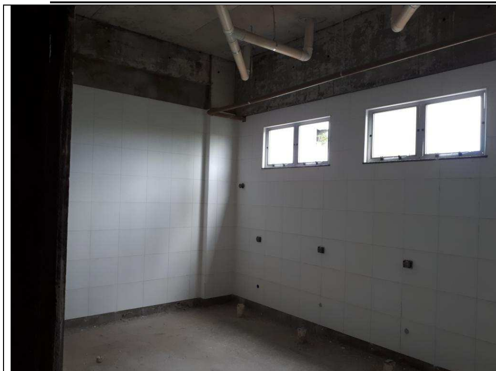
Foto 41 – Vista interna do Sanit Masc. do segundo andar. Revestimento cerâmico das alvenarias já aplicado. Instalação hidráulica e de esgoto executadas.
