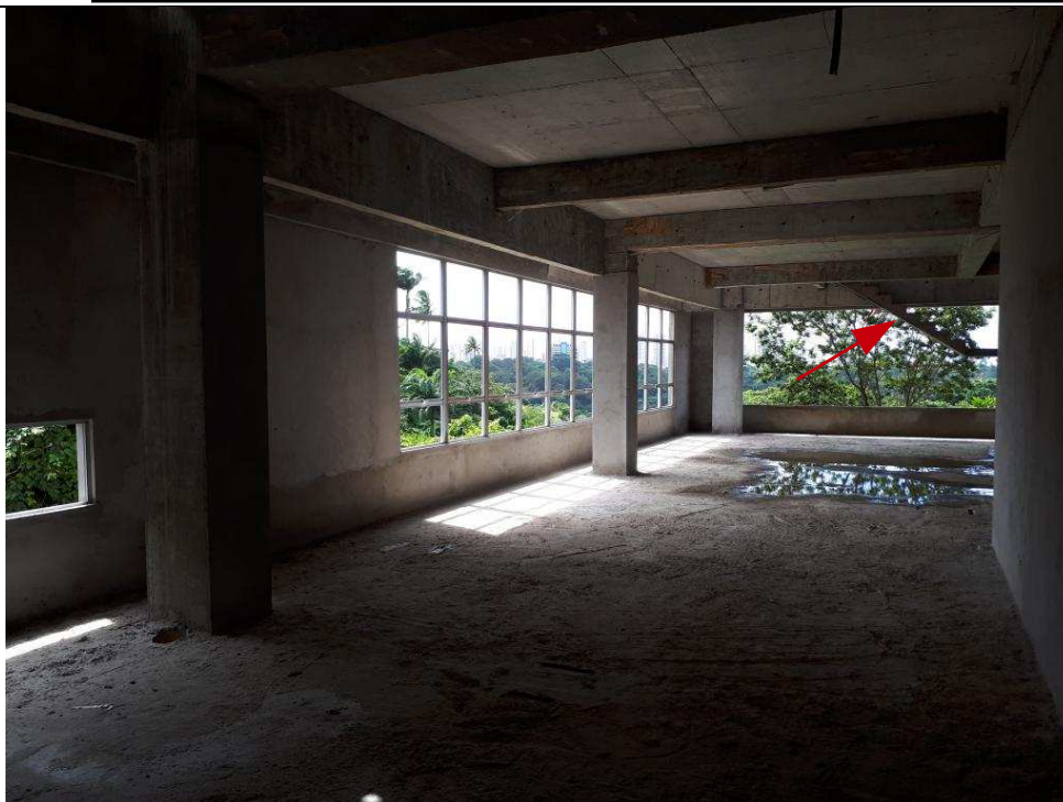
Foto 28 – Vista do primeiro andar. Alvenarias marcadas, levantadas e rebocadas. Detalhe da escada entre acervos concretada e desformada.
